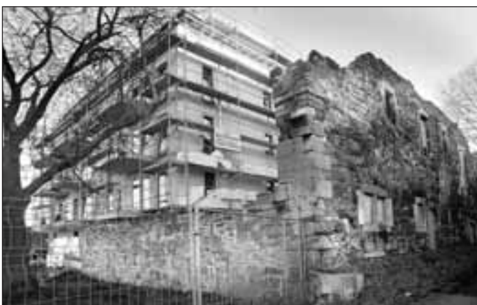
Schnell gewachsen: Das Wohnhaus in den historischen Überresten der Unterneustädter Mühle ist bald fertig.
