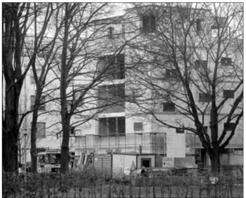
Der Rohbau steht: Neben dem kleinen Park an der Sternstraße bauen die Vereinigten Wohnstätten 1889 Eigentumswohnungen.
