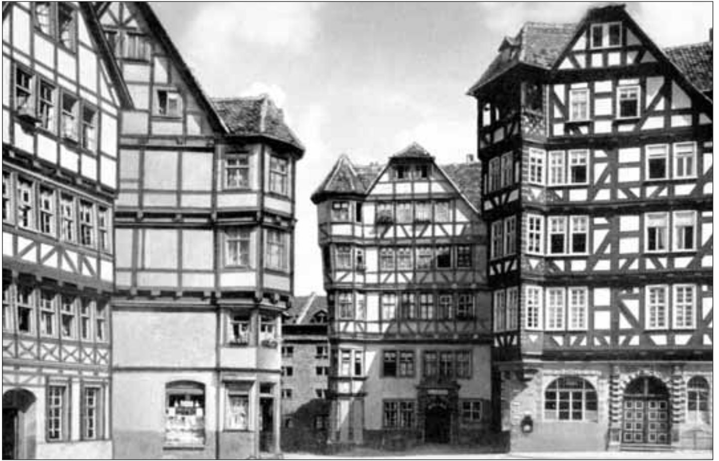
Schmucke Fassaden: Die Ostseite des Altmarkts Mitte der 1930er-Jahre.
